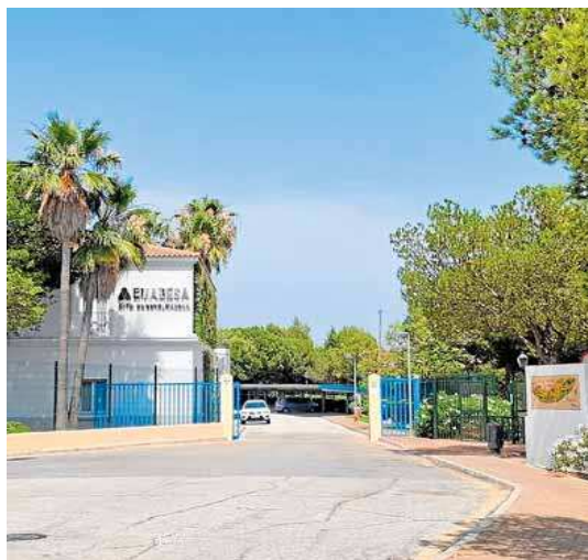
Vista de las oficinas de Emabesa. L. CÁDIZ
