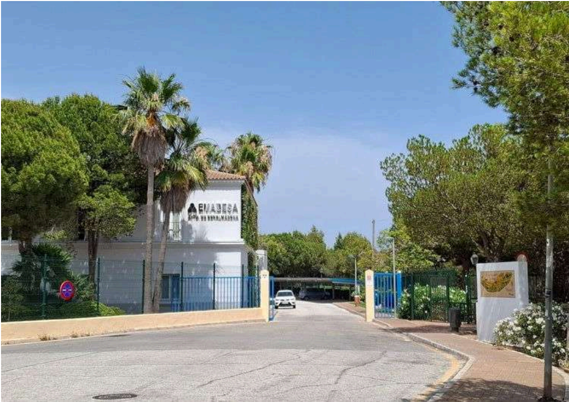
Vista de las oficinas de la empresa de aguas de Benalmádena, Emabesa.
